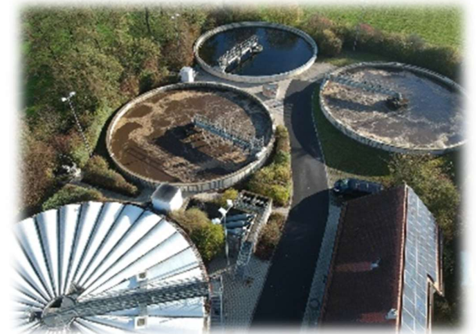
Unsere Kläranlage in Hirschau von oben
